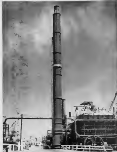
STACK IN PLACE, stiff-legged crane still holds it. STACA NA SU LUGAR, ainda e grua ta tene'le.
